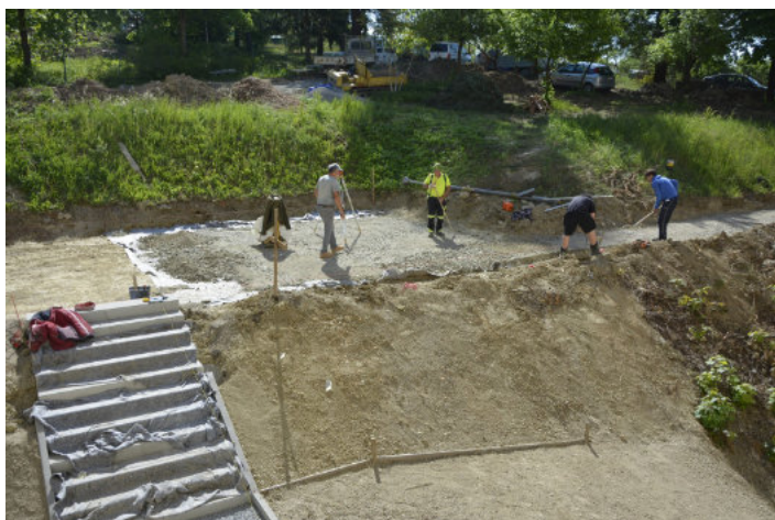
Stavební úpravy terénu a nástupní evakuační plochy.
